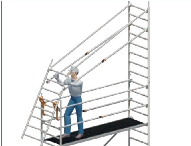
1. Aufstecken der ersten Standleiter. Anbringen der Uni Montagehaken und Positionierung der zweiten Standleiter zur Montage der Geländer und den Uni Telegeländern als Zwischenholme.
